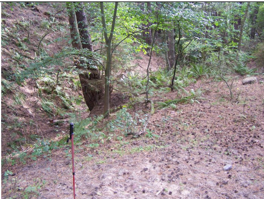
Dolna część osuwiska.
