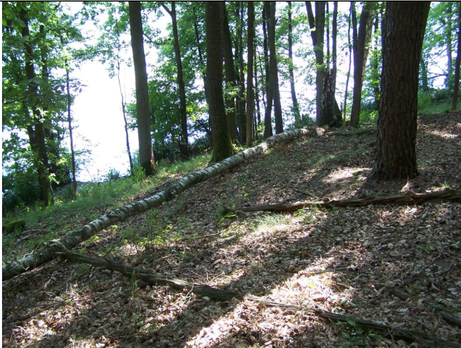
Dolna część osuwiska.
