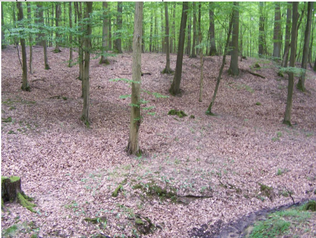
Widok na fragment osuwiska.
