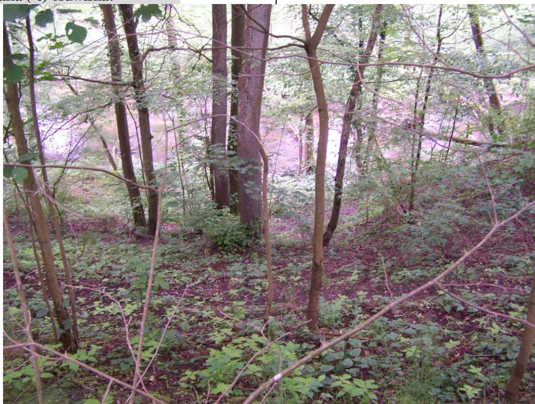
Widok ogólny na dolną część osuwiska.
