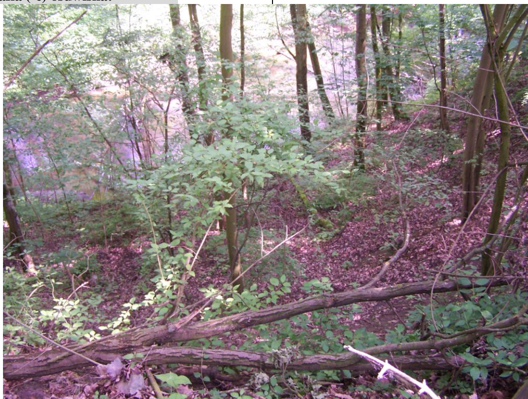
Widok ogólny na osuwisko ze skarpy.
