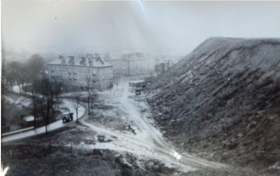
Osuwisko w 1969 r.
