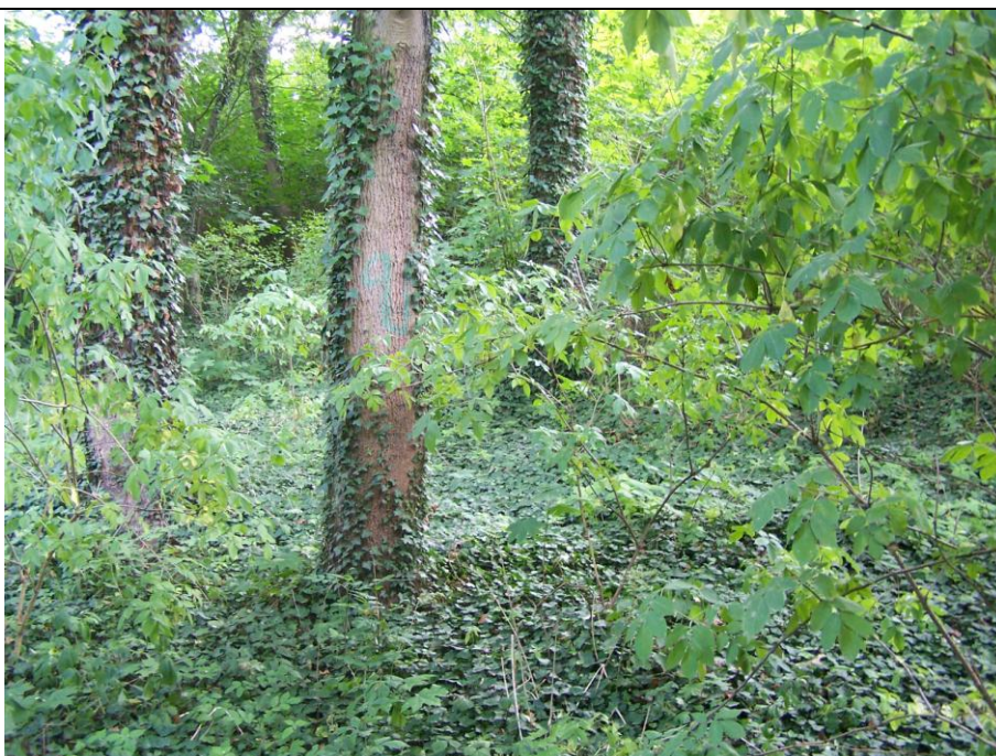
Ogólny widok osuwiska.
