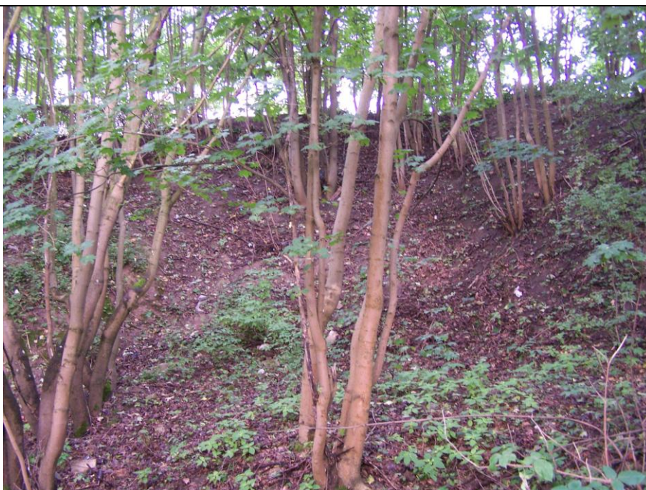
Ogólny widok osuwiska.
