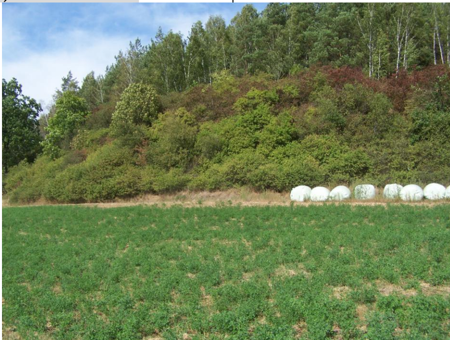
Widok ogólny na obszar osuwiska.
