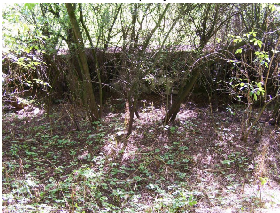
Widok z góry na mur oporowy.
