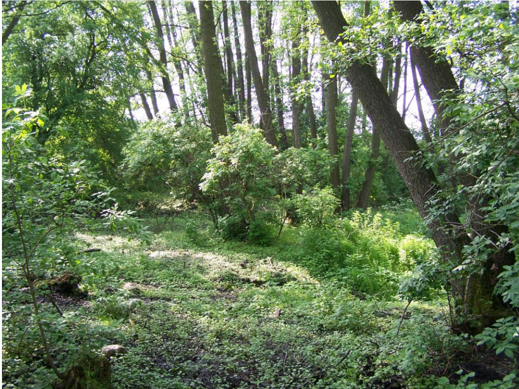
Widok na fragment osuwiska.
