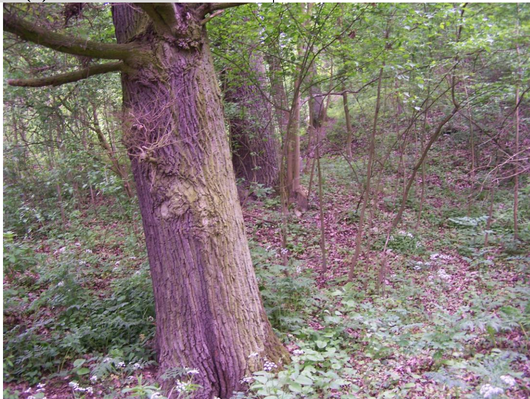
Widok ogólny na fragment osuwiska.
