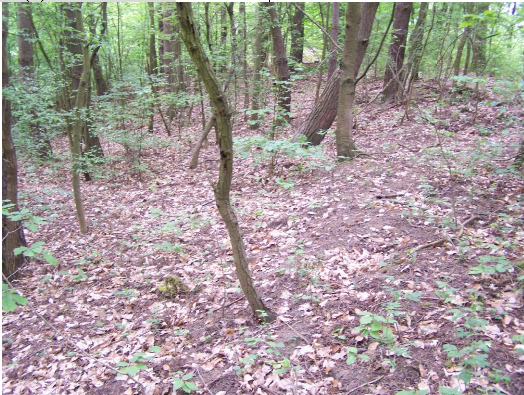
Widok na fragment osuwiska.
