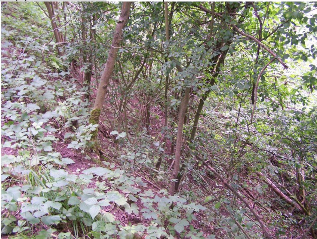
Widok ogólny na górną część osuwiska.
