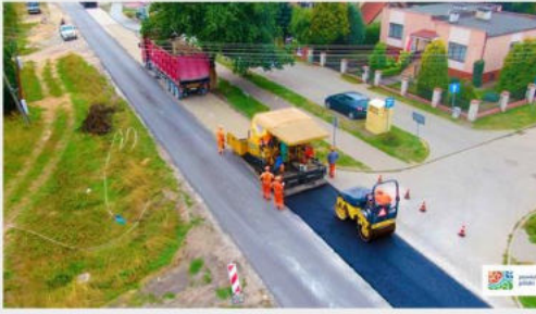
Przebudowa ul. Kamiennej w Pile
