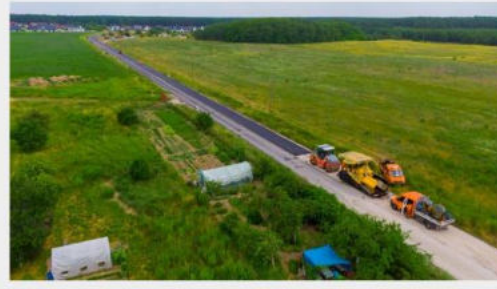
Przebudowa ul. Kamiennej w Pile
