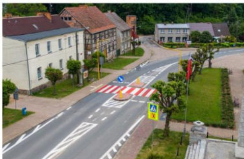
Zmodernizowane przejście dla pieszych w Miasteczku Krajeńskim
