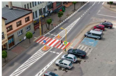
Zmodernizowane przejście dla pieszych w m. Wysoka
