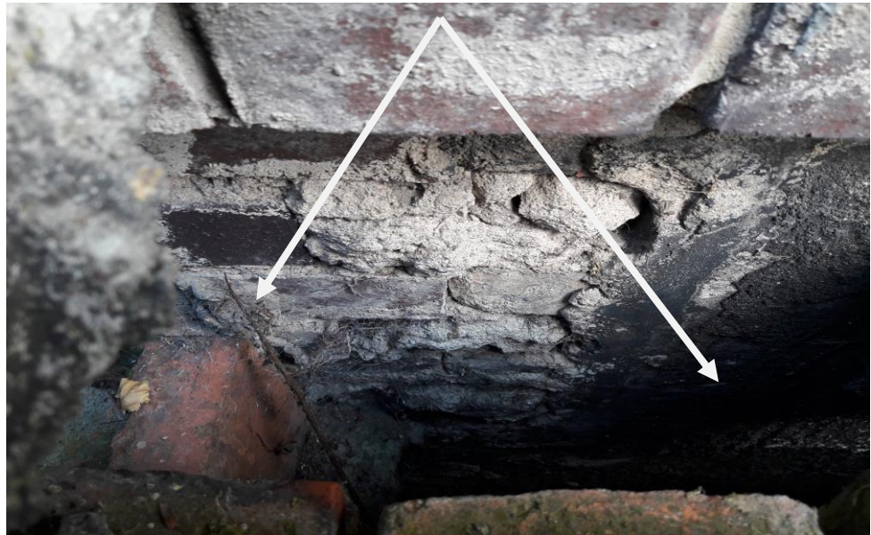
Fot. Resztki izolacji pionowych bitumicznych (ściana od strony ulicy)
