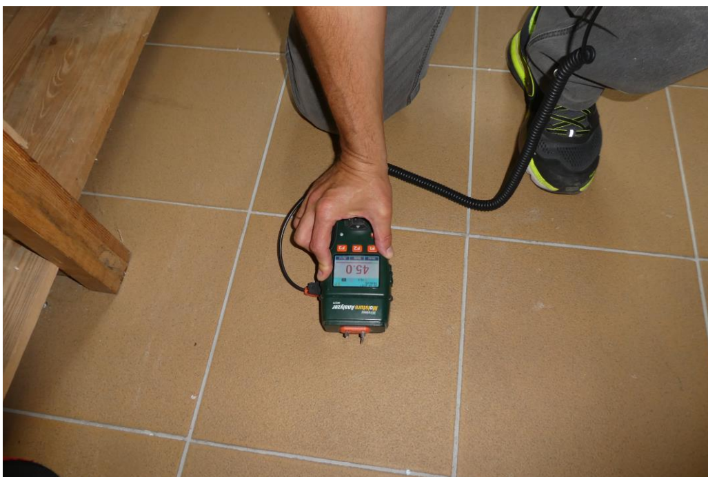
Fot. Pomiar wilgotności względnej posadzki w pom. nr 1 Wydział Komunikacji
