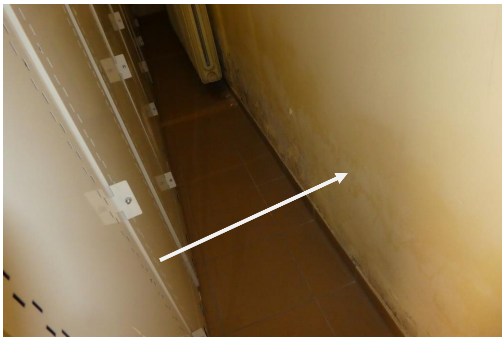
Fot. Mokra ściana zewnętrzna w pom. 13 Wydział Komunikacji
