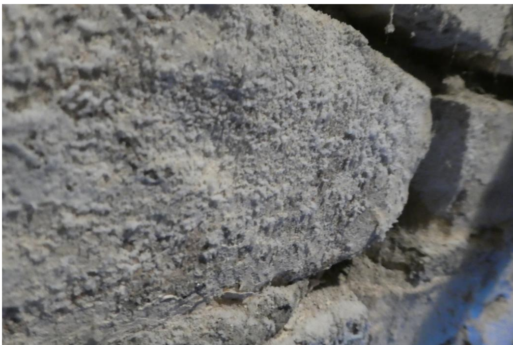
Fot. Pomieszczenie j.w. wysolenia na ceglach
