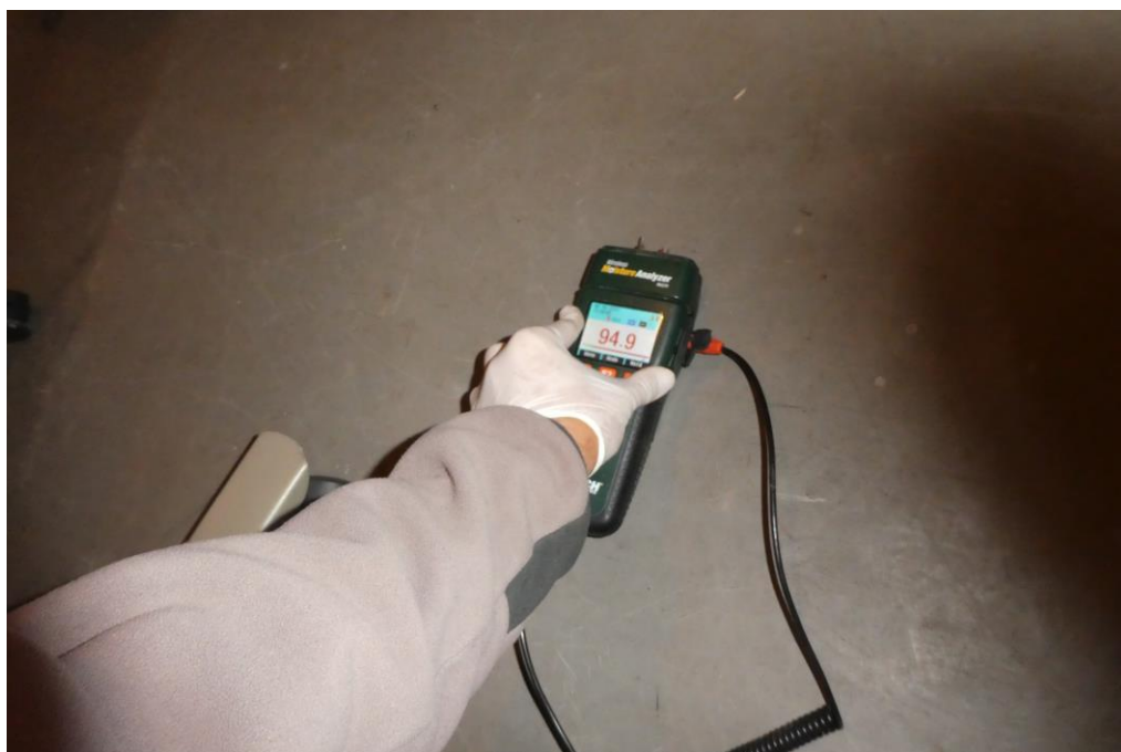
Fot. Pomiar wilgotności względnej posadzki w pomieszczeniu nr 004: 94,9%
