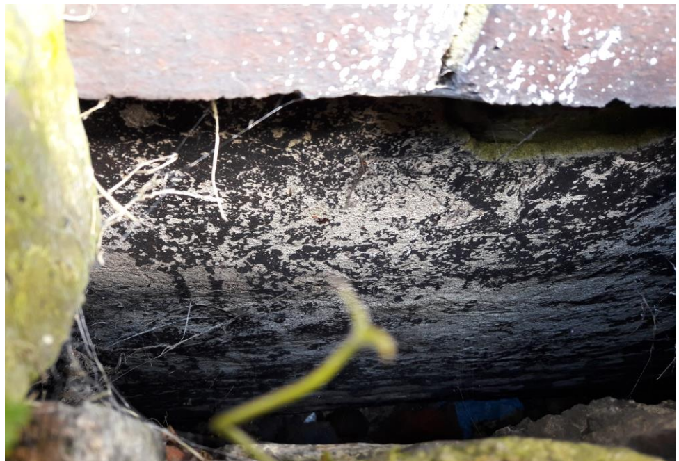
Fot. Izolacje pionowe j.w.
