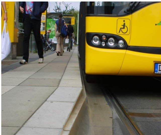
Rys. 8.6.1. Zalecane ukształtowanie krawędzi peronowej.
