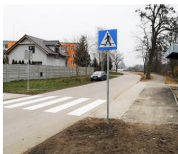
Chodnik przy drodze powiatowej w miejscowości Kotuń
