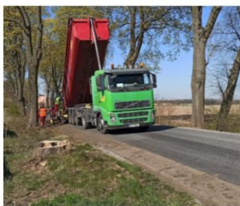
Wykonanie nakładki bitumicznej na drodze powiatowej Fanianowo-Dębno
