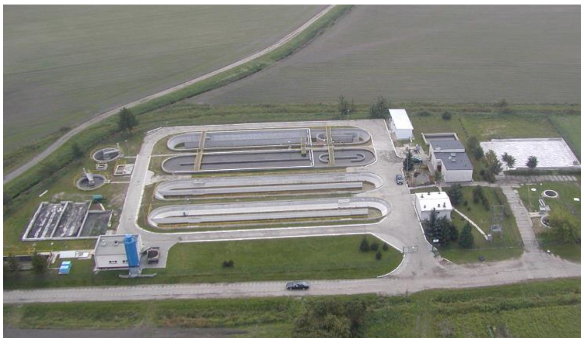
Ryc. 23. Oczyszczalnia ścieków w Wysokiej
