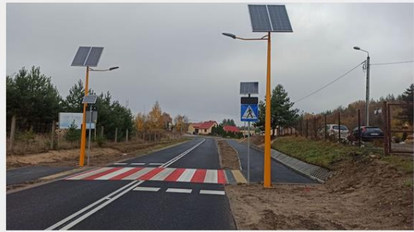
Droga powiatowa w m. Krzewina po remoncie
