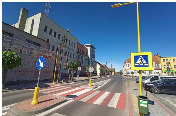
Zmodernizowane przejście dla pieszych w m. Wysoka
