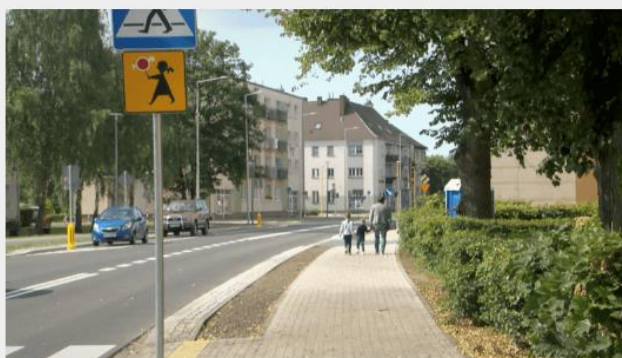
Przebudowana ul. Okólna w Pile
