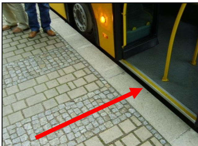
Rys. 8.6.2. Strefa wejściowa – inny rodzaj nawierzchni naprzeciwko pierwszych drzwi autobusu. Źródło: materiały własne TRAKO.
