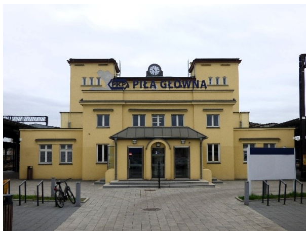
Fot. 18. Dworzec kolejowy w Pile
